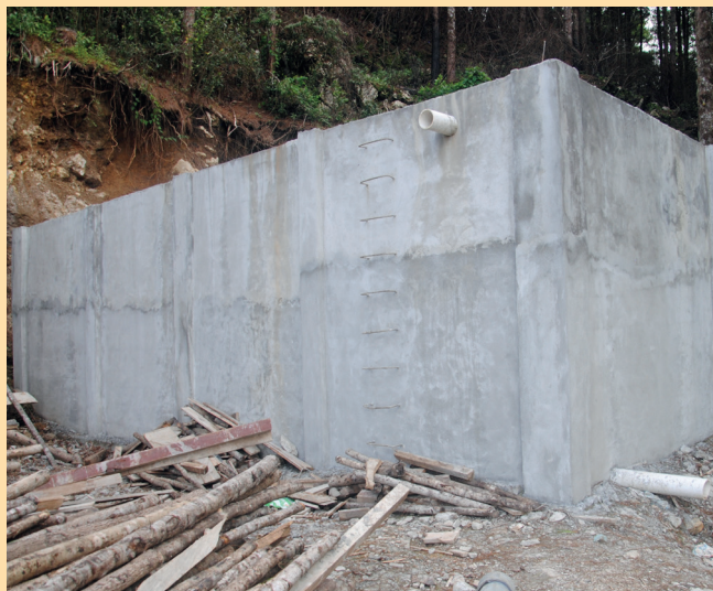
NYBYGGD TANK. Steg för steg bygger byn sitt nya vattennät. I Guatemala finns inte möjlighet att vänta på att kommunen ska träda in. Istället betalar varje familj en slant var.
