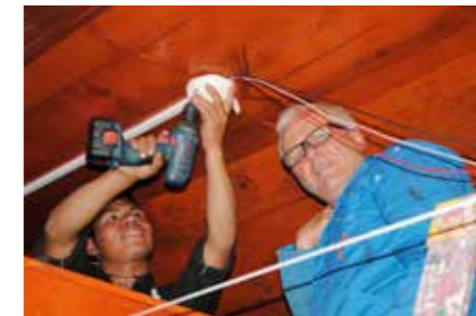
INSTALLATION. Janos Szemler, föreningens revisor, installerar el med lärlingen Francisco i gästrummen.
